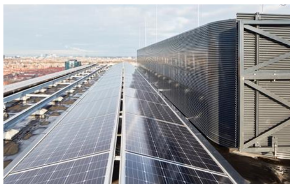
Photo du toit d'Atrium situé à Amsterdam aux Pays-Bas
