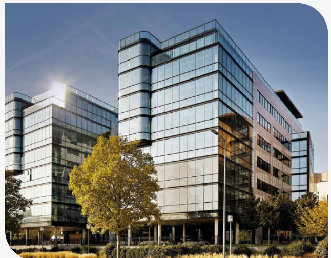
Immeuble « Seine Avenue »
