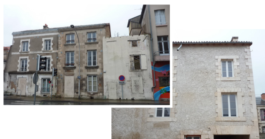
10, rue St Cyprien / 64, Boulevard A. France
