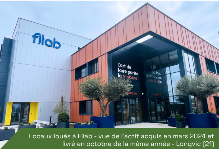
Locaux loués à Filab - vue de l'actif acquis en mars 2024 et livré en octobre de la même année - Longvic (21)
