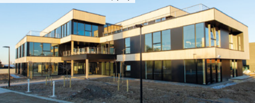
La Pilaterie – Villeneuve-d'Ascq (59)
