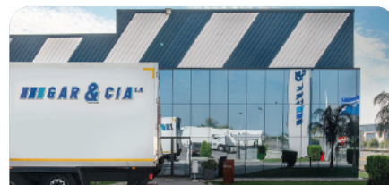
Séville (Espagne) 10 808 m² | entrepôt logistique Taux d'occupation : 100% Monolocataire Acquis le 1 er août 2024
