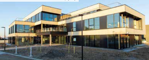
La Pilaterie – Villeneuve-d'Ascq (59)
