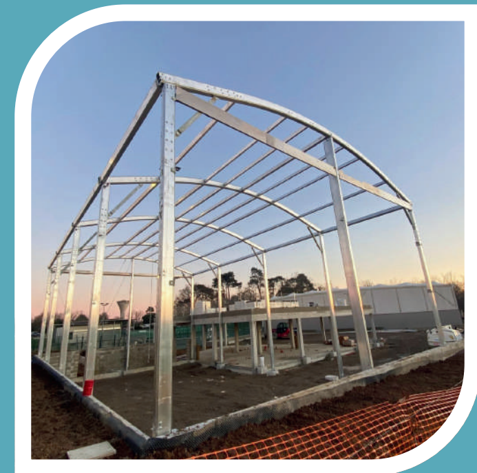
Construction du centre de padel à Camblanes-et-Meynac (33)
