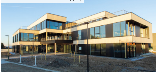
La Pilaterie – Villeneuve-d'Ascq (59)
