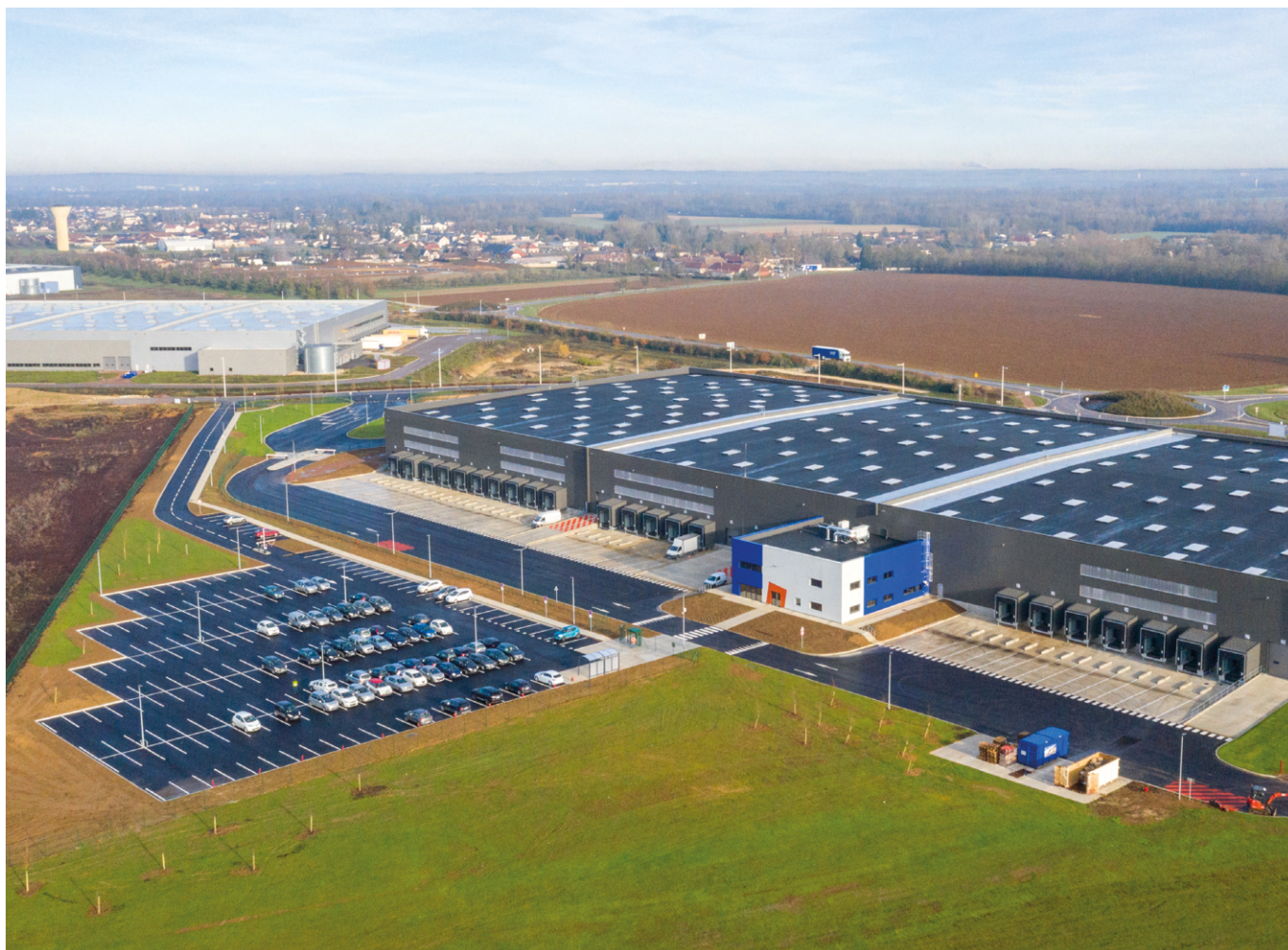
Zac du Parc Logistique de l'Aube - Troyes
