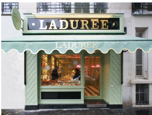
14 rue de Bretagne - Paris 3 e
