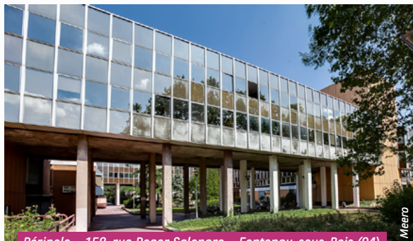
Péripole - 158, rue Roger Salengro - Fontenay-sous-Bois (94) (actif cédé)
