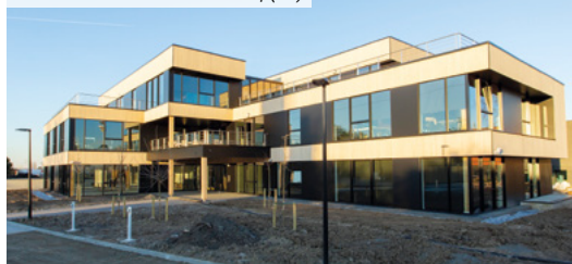
La Pilaterie – Villeneuve-d'Ascq (59)
