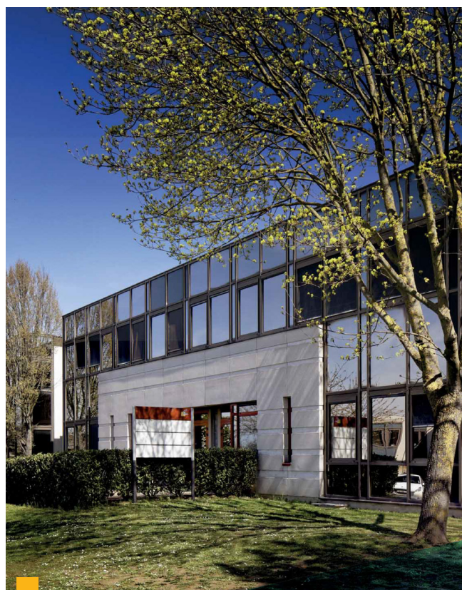
Rue le Corbusier, CRETEIL (94)
