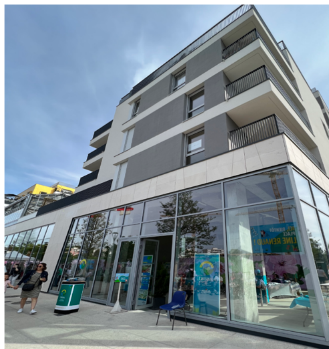
Boulangerie en cours d'installation - Rueil Malmaison
