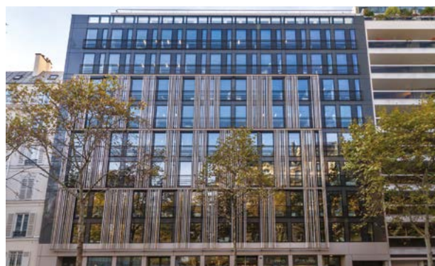
170, boulevard du Montparnasse - Paris (75014)
