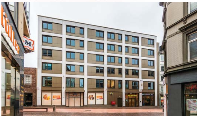
Grobkölstraße 57-63 - Aix-la-Chapelle (Allemagne)
