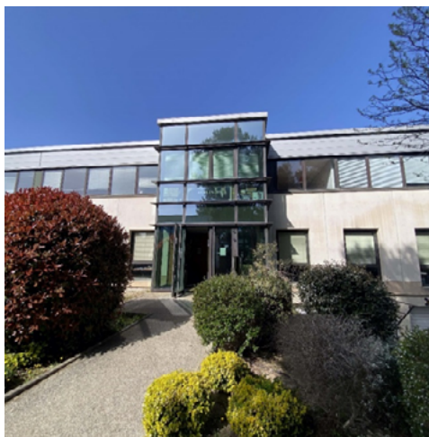
Bureaux «Le Sirocco» – Aix-en-Provence
