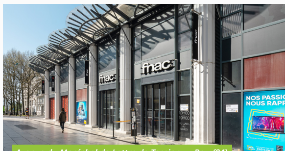
Avenue du Maréchal de Lattre de Tassigny - Pau (64)
