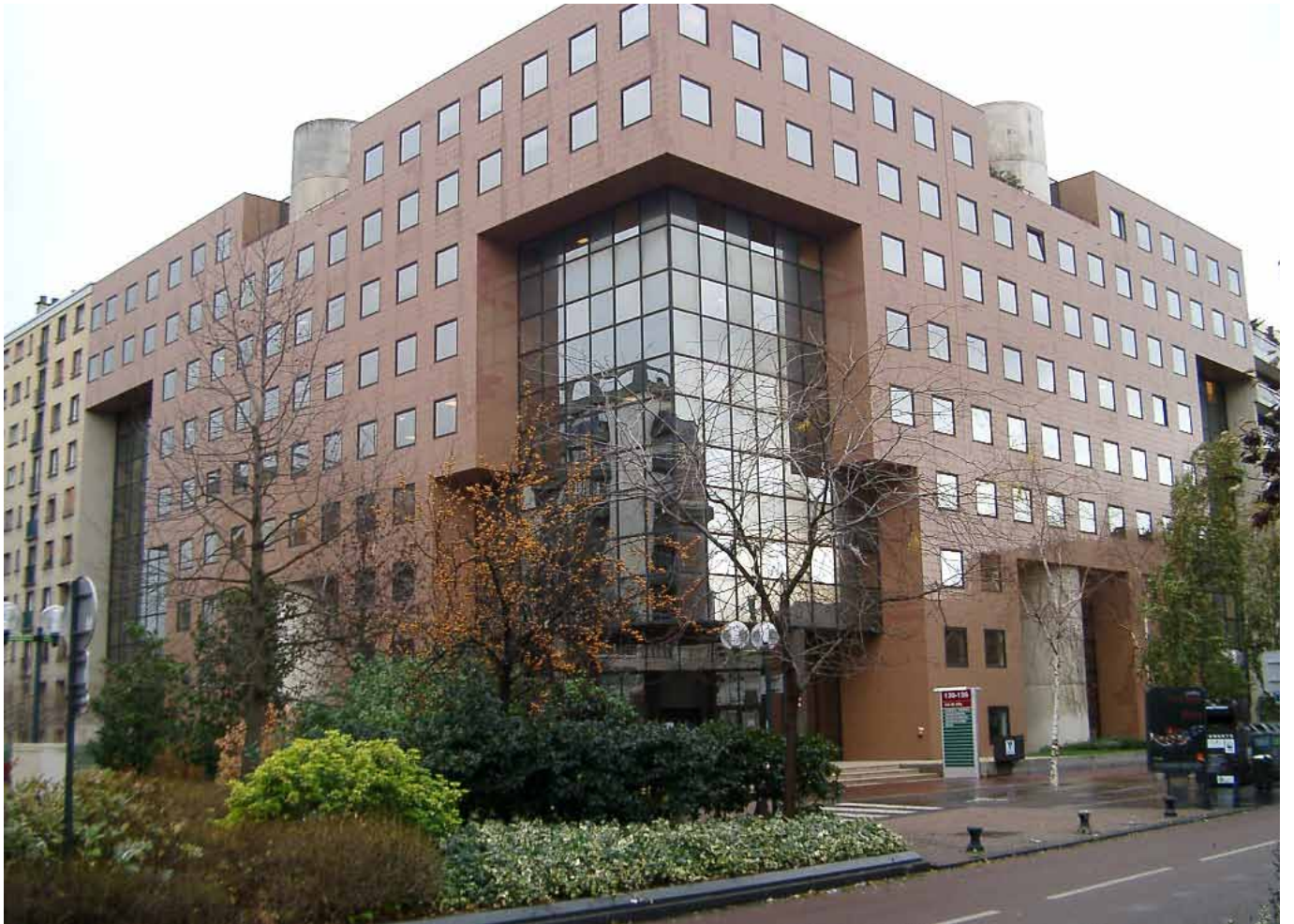
Allianz Pierre - 130-136 rue de Sily - Boulogne-Billancourt (92)
